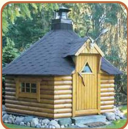
**Stěny** - 120mm kulatá stěnovice (půlkuláč) z finské borovice. Výška stěny činí cca 128 cm. Stěnové prvky jsou upevněny systémem tálka.
