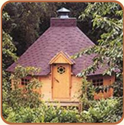
**Stěny** - 45mm stěnovice (fošny) z finské borovice, výška stěny činí cca 140 cm, Stěnové prvky jsou upevněny systémem táhla
